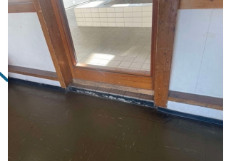
Terskel – 70mm høydeforskjell mellom gulv vestibyle og bassengrommet
