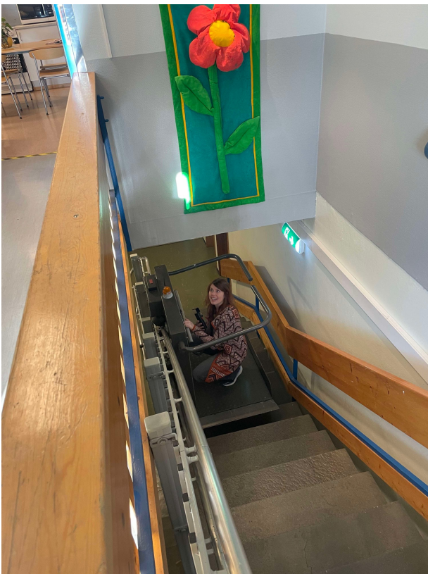
Trapp med trappeheis ned til kjellerplan
