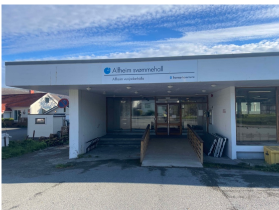
Adkomstsone med provisorisk rampe
